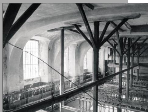
Salle de dévidage de la Fabrique Haute
